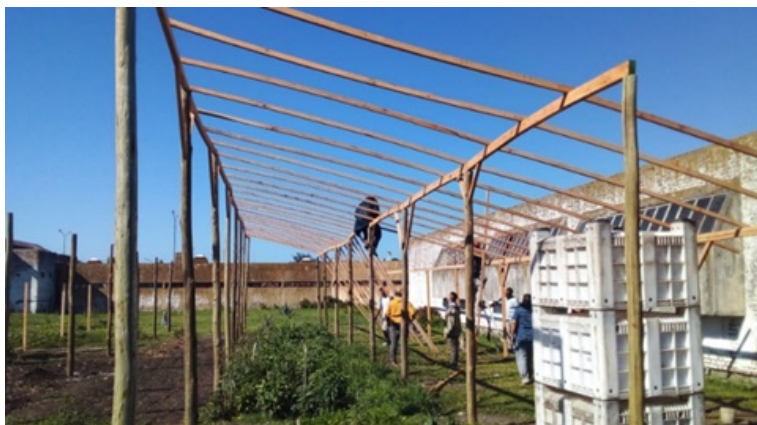
Figura 29. Construcción de invernadero en la Unidad Penal de Batán, Cooperativa de trabajo Liberté
